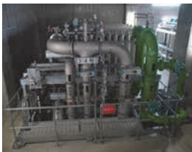
写真-3 膜汚過ユニット
