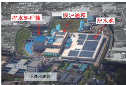
写真-2 航空写真（平成25年8月撮影）
