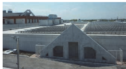
写真-7 新設配水池と膜汚過棟
