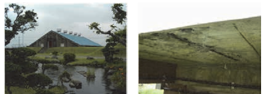
写真-1 1号配水池及び沈でん池の老朽化
