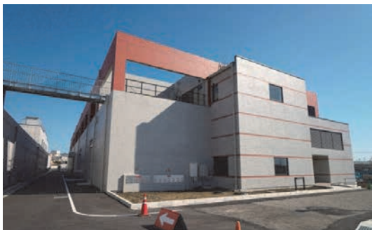
写真-5 セラロック膜汚過棟
