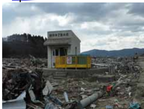
宮城県南三陸町助作第2取水場
