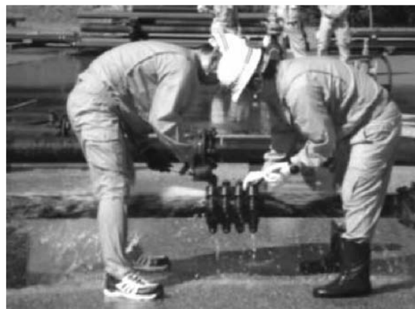
漏水修理の実習
