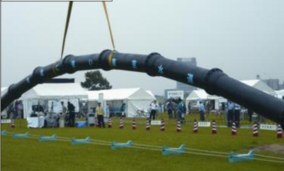
耐震継手管吊り下げ実験
