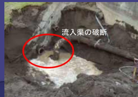
下水処理場の被害 (④北海道胆振東部地震)
