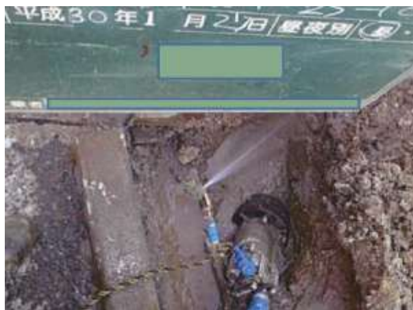
①浅層埋設部における継手漏水
