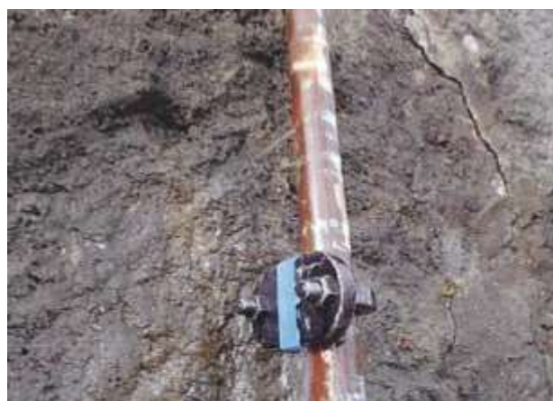
②保温対策がされていない露出配管からの漏水
