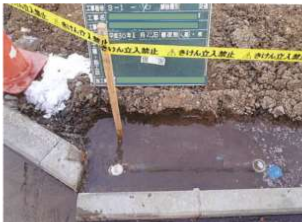
①浅層埋設部における継手漏水
