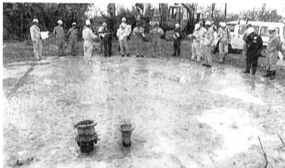
沢配水池（一関市）跡地で説明を受ける
