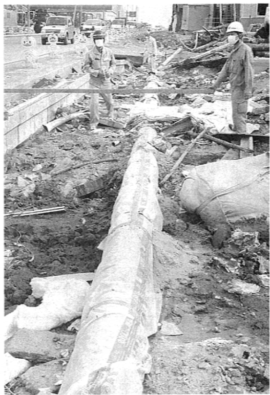
津波被害地区の石巻市内で被害がなかったNS形ダクタイル鉄管。災害復旧も耐震化が求められる
