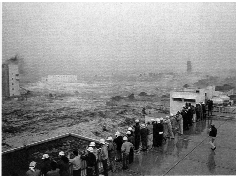
仙台市の南蒲生浄化センターでは、発災直後に職員ら関係者が管理棟屋上に避難。押し寄せる津波のみ込まれる施設を前に、言葉を失った（仙台市提供）
