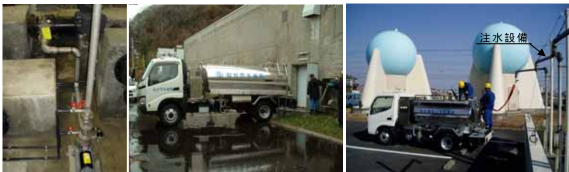
耐震性貯水槽と立上り配管による注水状況
