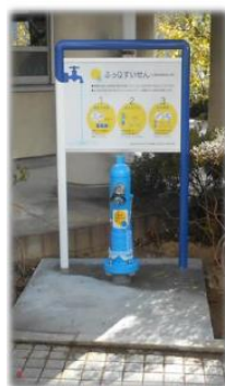
説明用看板と地上式給水栓
