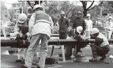
管路の漏水箇所を補修材料・器具を用いて止水した応復旧訓練
