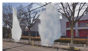
被害箇所：駿河区 ツインメッセ前 配水本管 φ150 DIP 漏水4箇所
