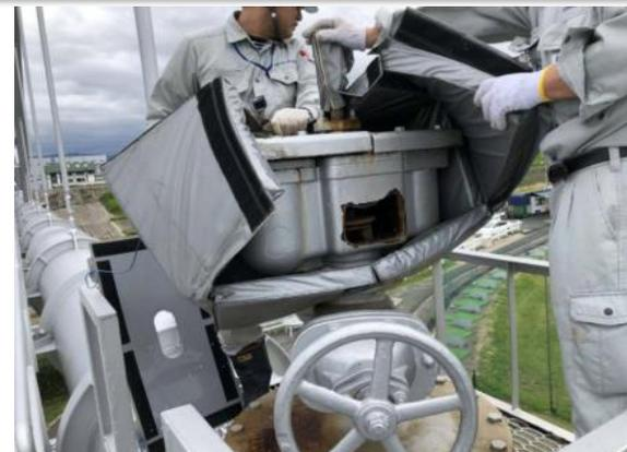
＜漏水箇所（FC製空気弁箱）＞
