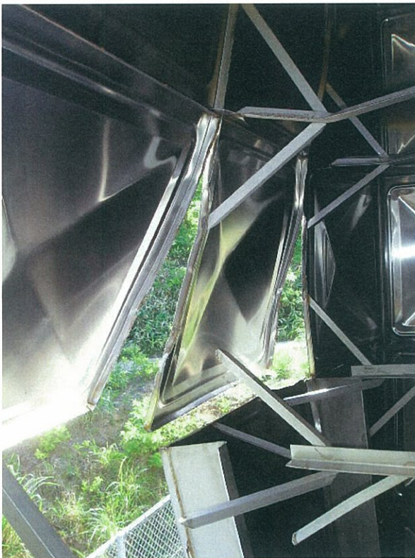
写真 5.3 剣地配水池の被害状況 (3)
