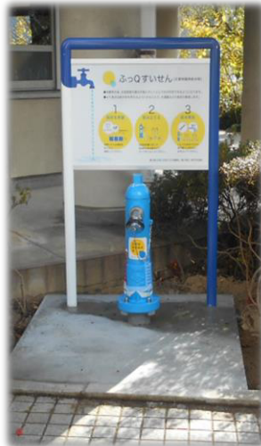
説明用看板と地上式給水栓
