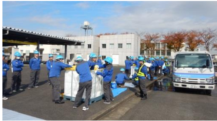
【仮設水槽の組立】
