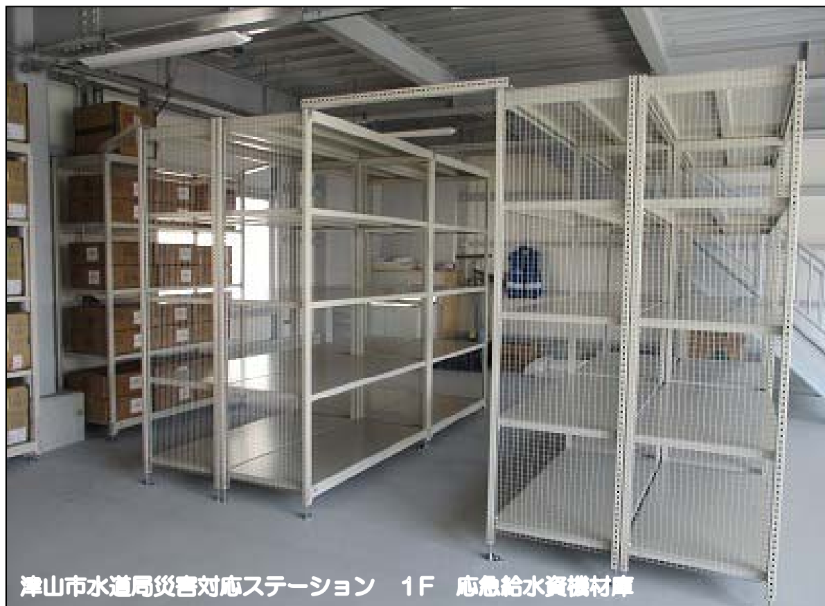
津山市水道局災害対応ステーション 1F 応急給水資機材庫
