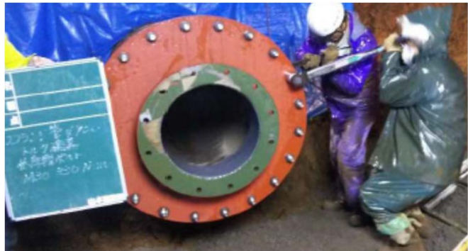
【φ900→500mm片落ち管設置状況】
