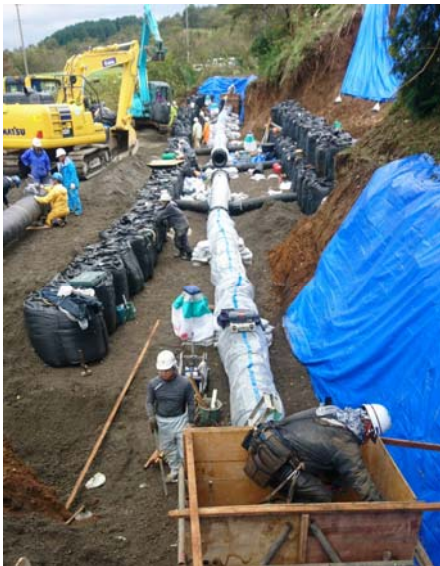
【2方向配管状況】
