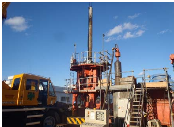
掘削機挿入状況
