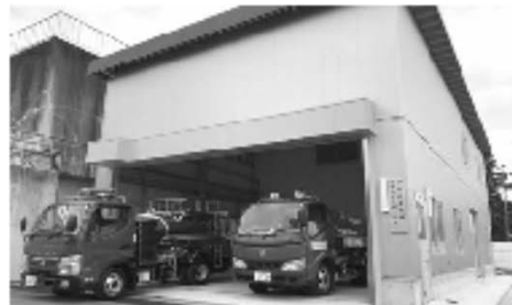
災害対応ステーションと追加配備した給水車
