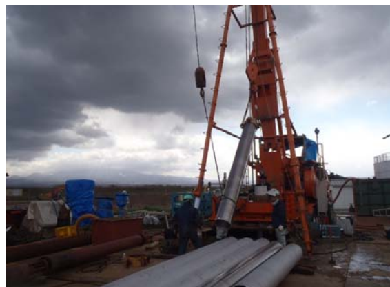
SUS製ケーシングパイプ挿入状況
