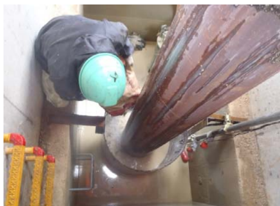
泥水処理状況
