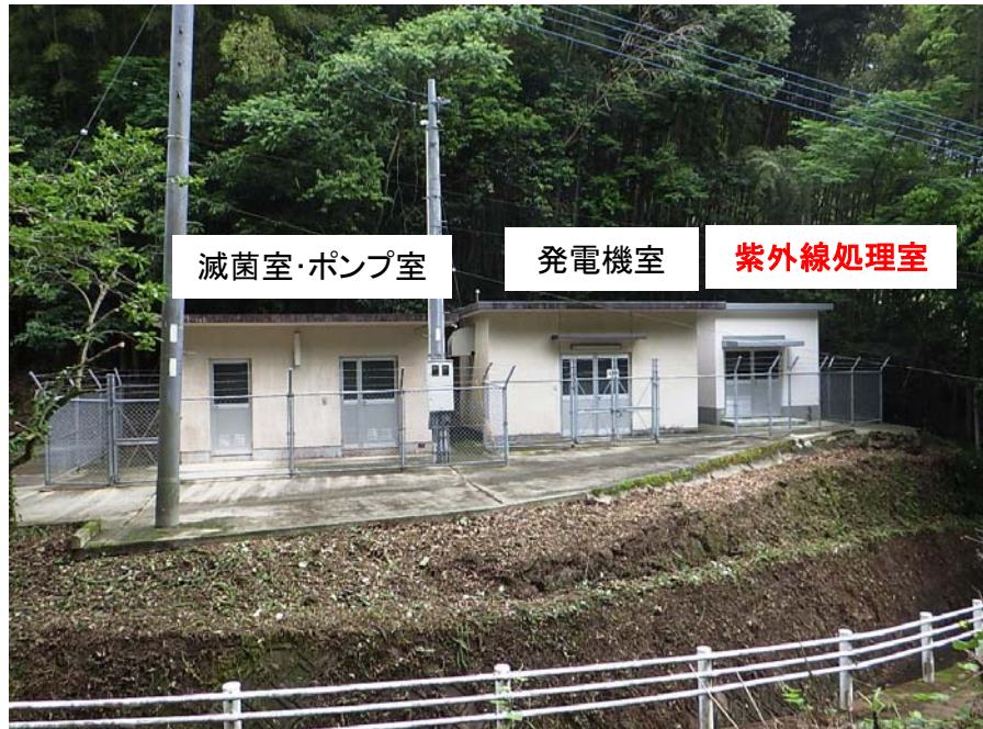
配置状況(写真)
