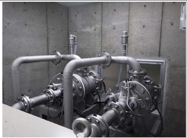
設備状況写真-2
