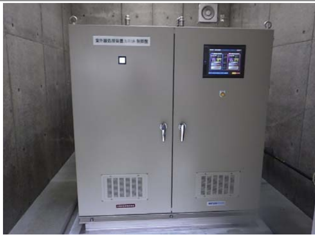
設備状況写真-1
