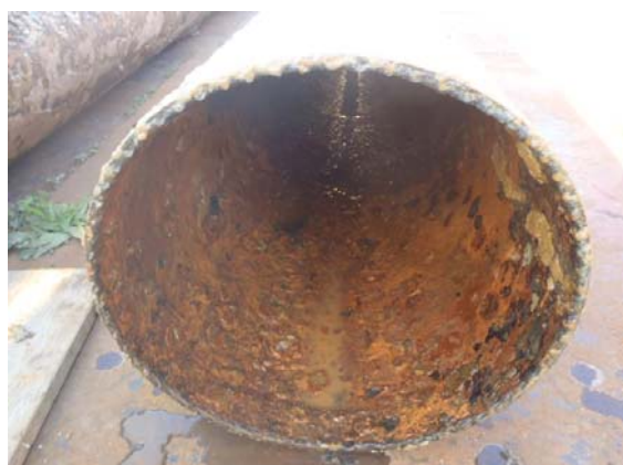
撤去した既設鋼製ケーシングパイプ
