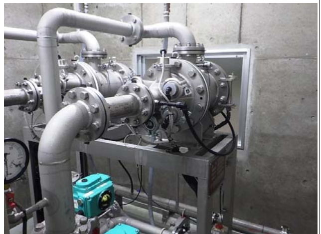
設備状況写真-4
