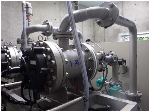
設備状況写真-3
