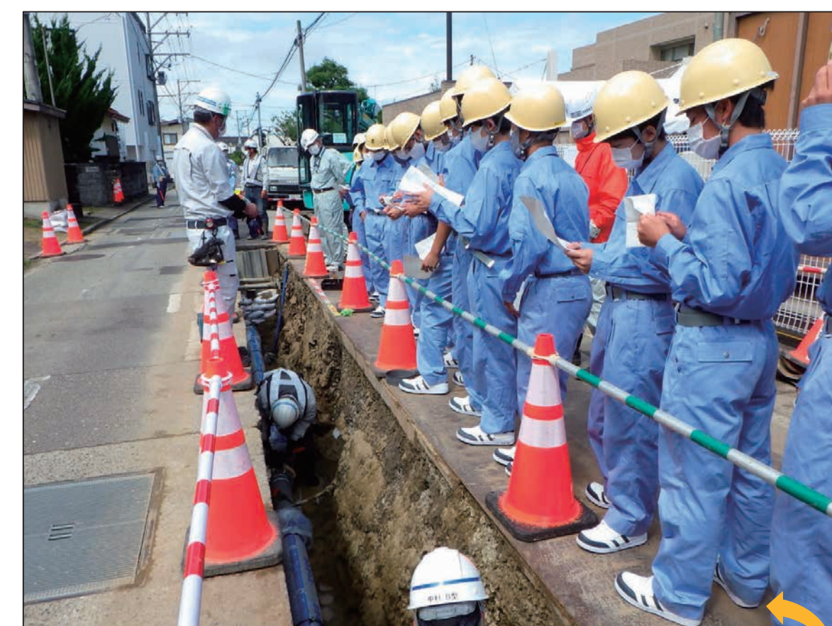
現場見学：工事箇所見学
