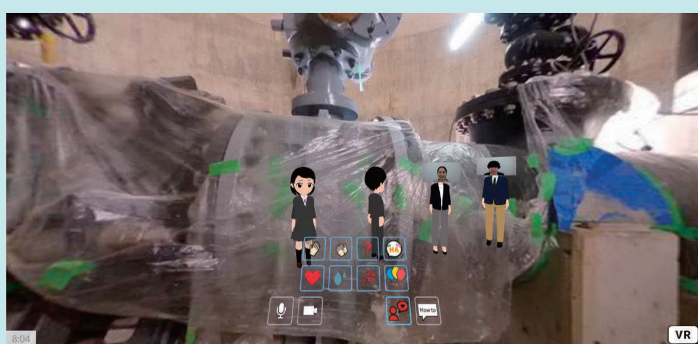
VRでの工事中の立坑紹介
