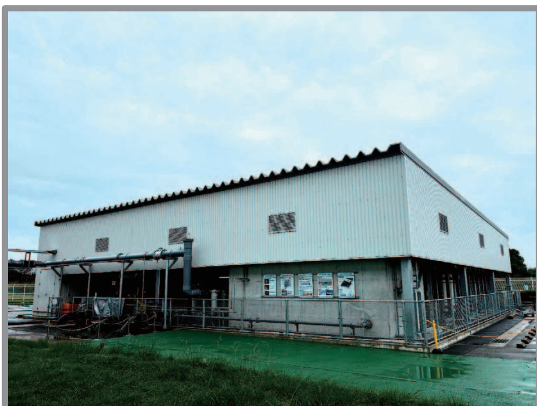
浸透圧発電施設全景
