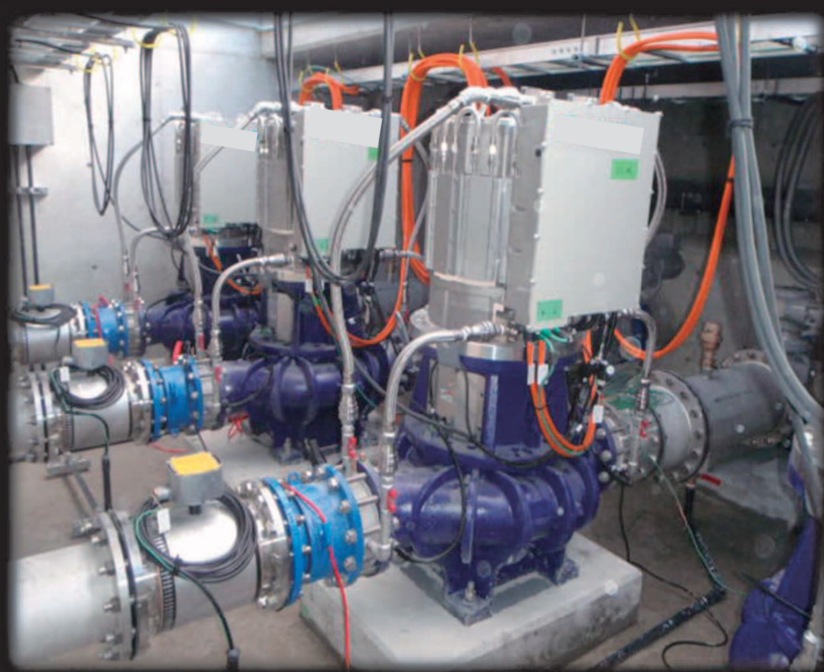
小水力発電（4基@75kW）
