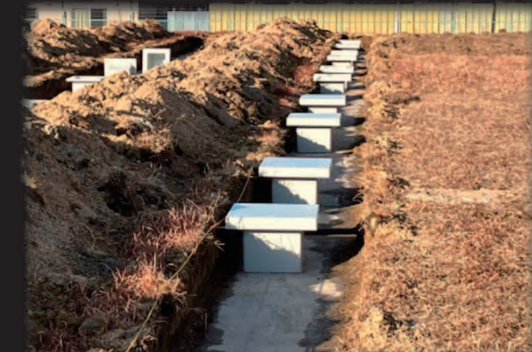
太陽光パネル基礎設置（配水池）
