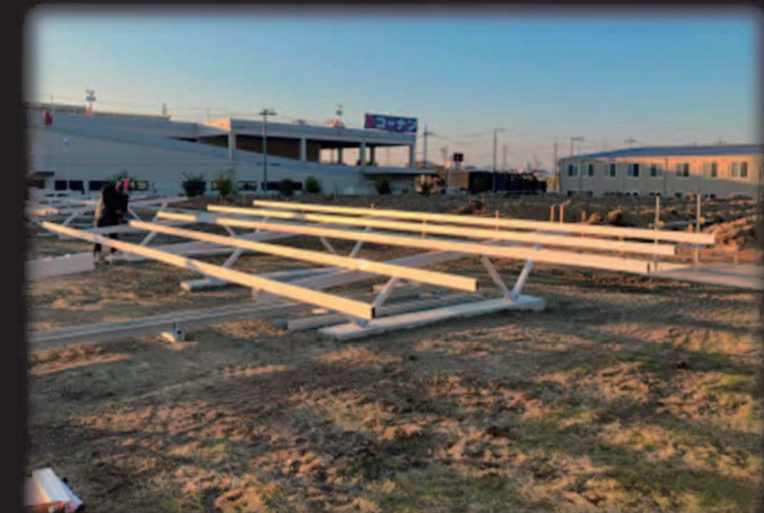
太陽光パネル基礎設置（受水池）
