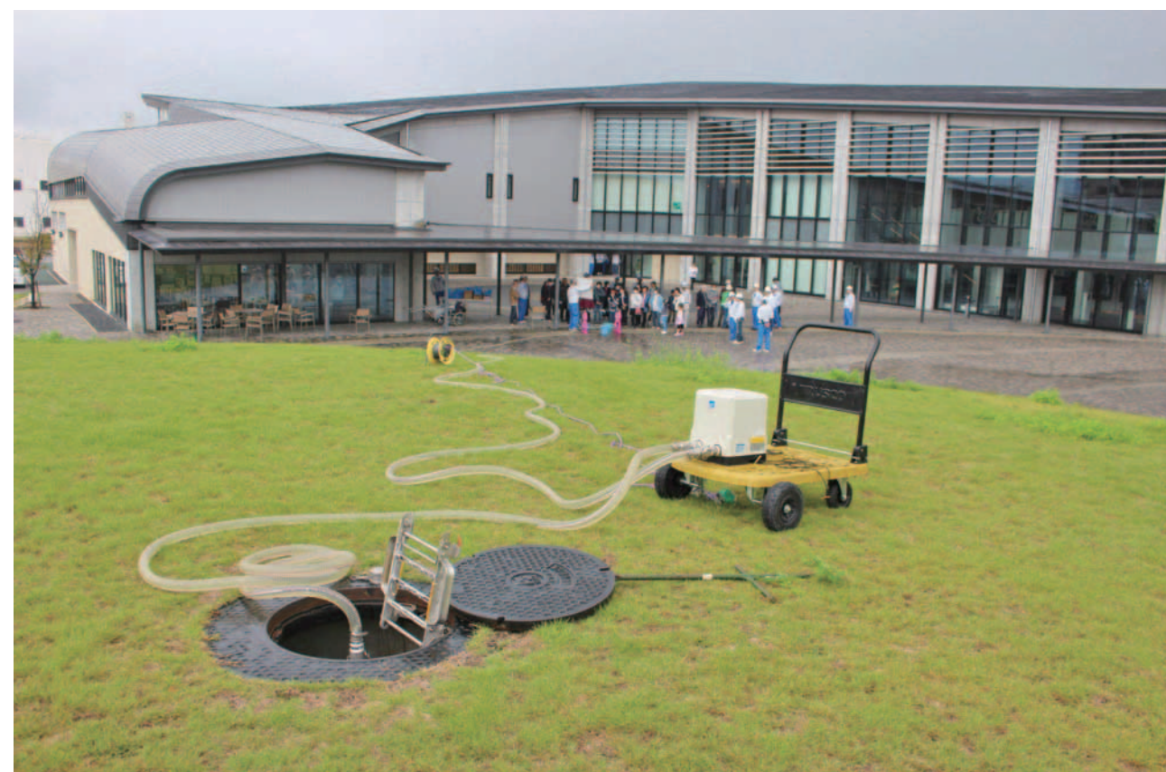
避難訓練では、敷地内に埋設されている耐震性貯水槽からの取水を実演
