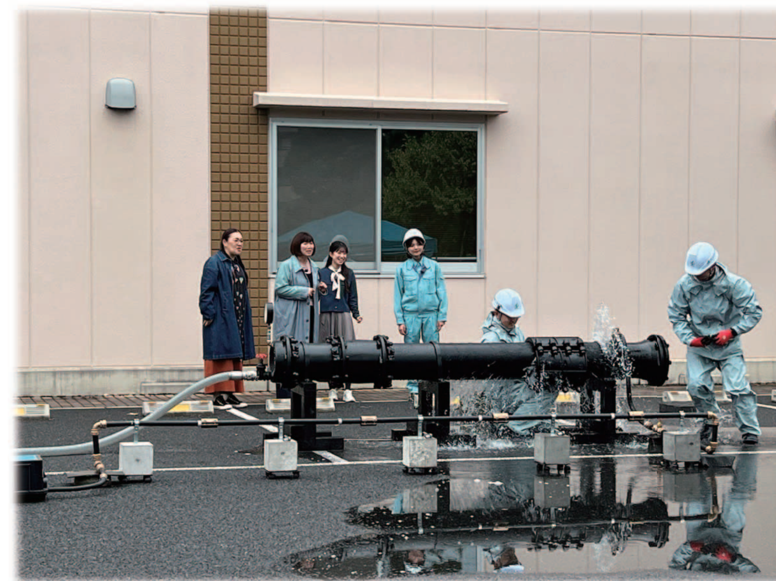
漏水修繕デモンストレーション
