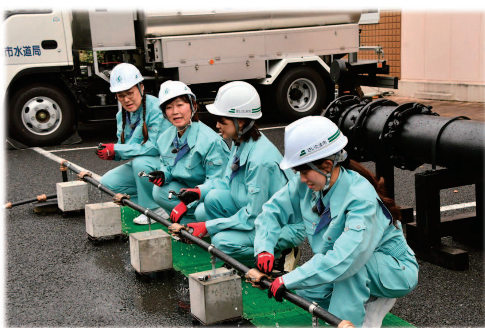
水道管の漏水修繕体験
