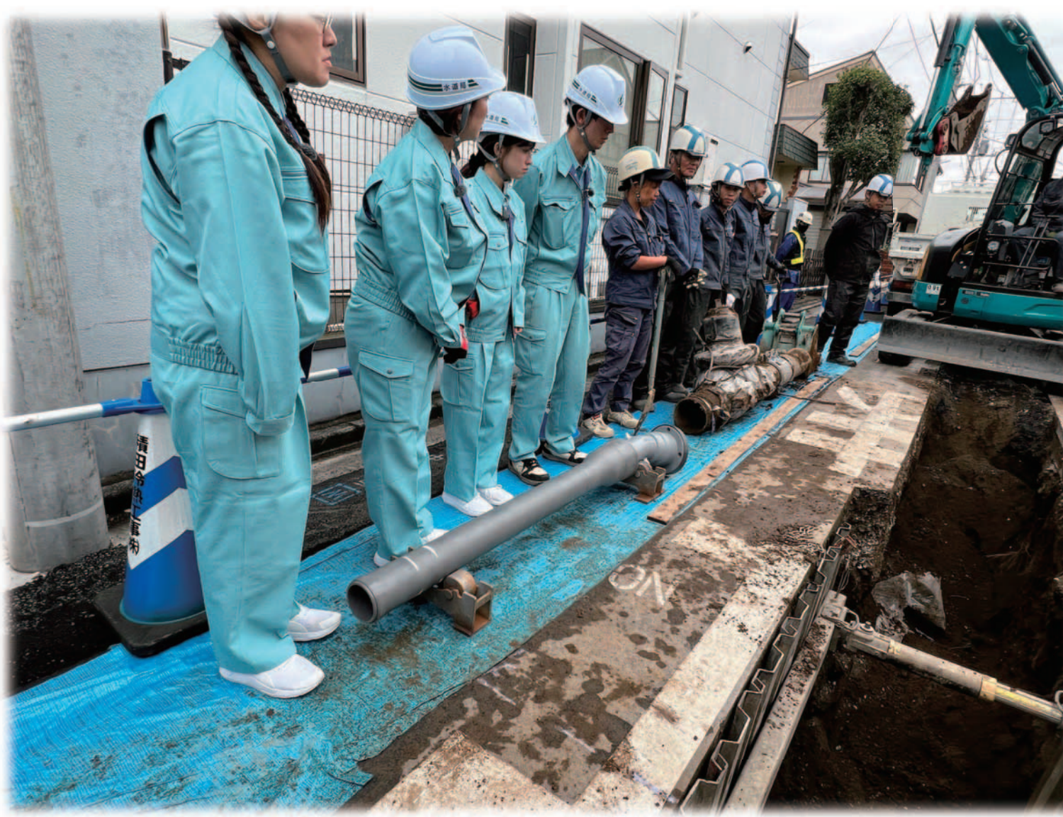
工事現場見学
