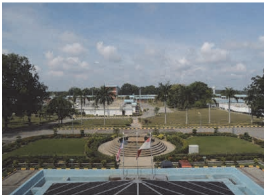
浄水場内の様子
