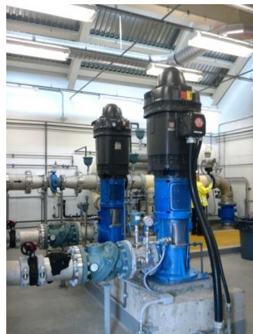
送配水システムの様子
