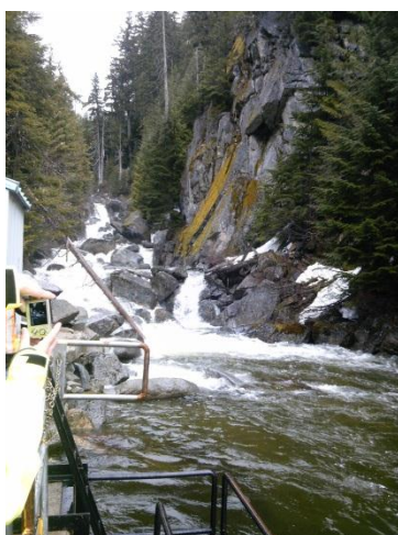
取水口付近の様子
