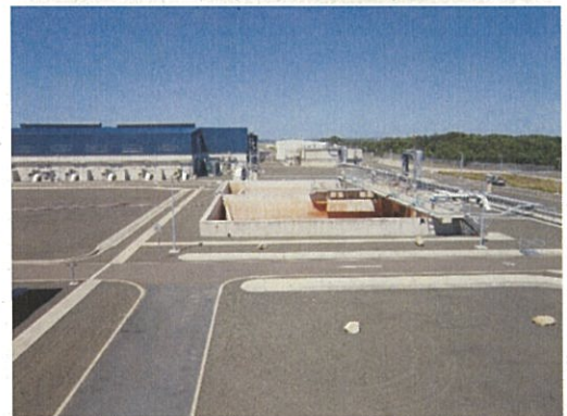
排水処理施設
