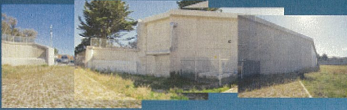
配水池を断層上から見る
