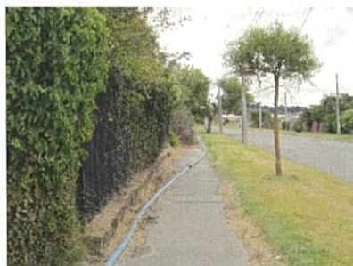
仮設水道配管
