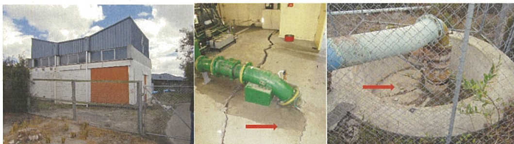
建屋と室内配管・井戸本体の被害状況（地盤自体が同方向へ移動している）
