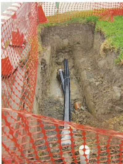
PE管引き込み完了
