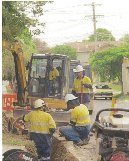
エンジンカッターによる既設管切断作業
