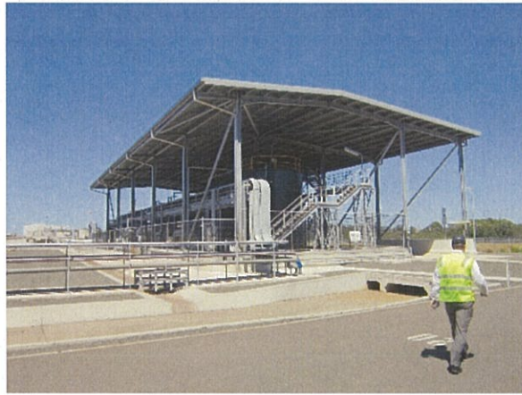
薬液注入施設
