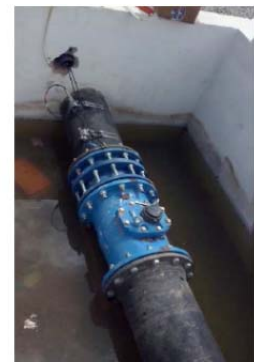
マスターメーターの設置
