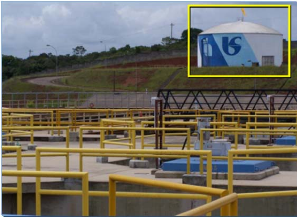
拡張箇所⑥ 洗浄水タンク(2,000m 3 )1基の増設
