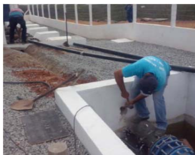
マスターメーターの設置
