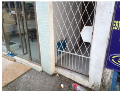
フェンス内のメーターボックス
