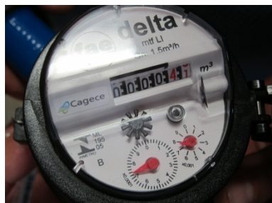
給水メーター
