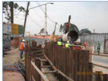
1800mm 配水管の布設状況
