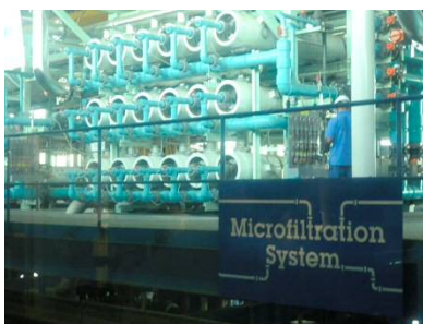
写真 11. 精密ろ過施設
