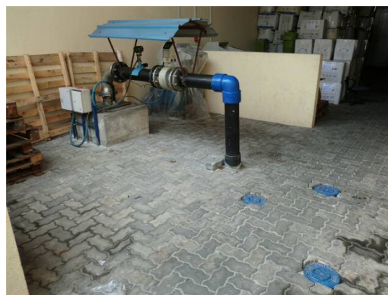
写真 30. MWSC 本社内の取水井
