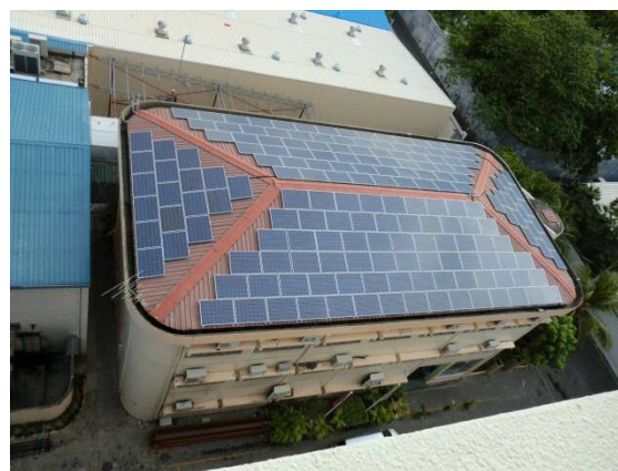
写真 32. ソーラーパネル設置状況
