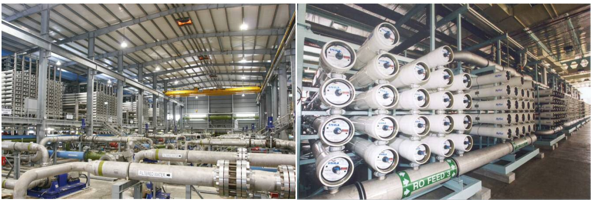
写真 27. 海水淡水化プラント (PUB ホームページより)
