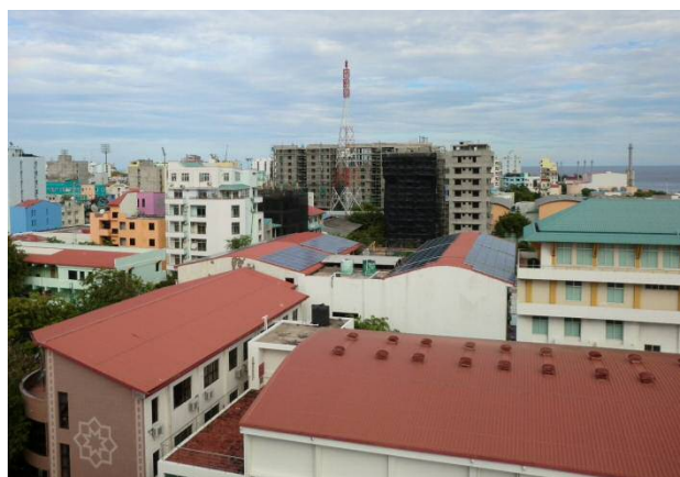
写真 34. 高層化を進める建築工事の様子
