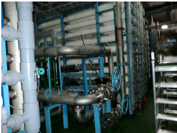
写真 7. 海水淡水化装置（RO 膜）
