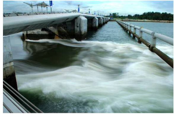
写真 21. 放水状況 (PUB ホームページより)
