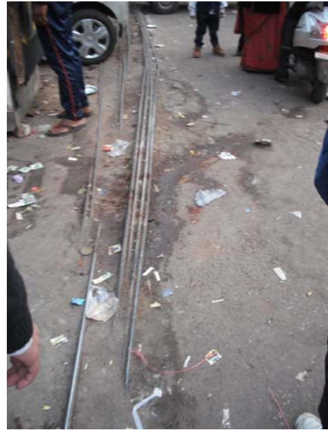
写真A 街中のスパゲティ配管
