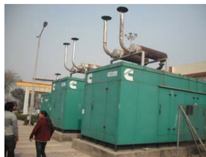
写真I 場内の発電機
