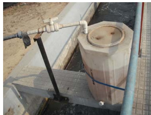
【写真E】 薬注設備が手動っぽい
