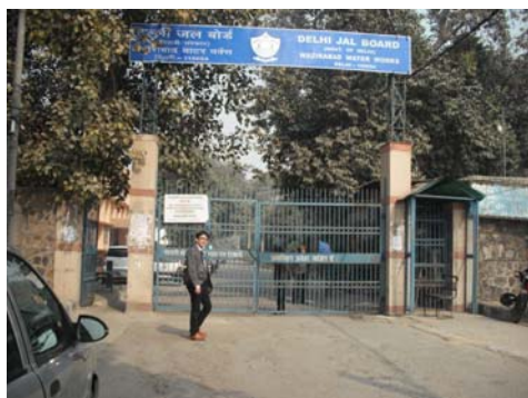
写真F-1 浄水場出入り口の警備は厳しい。
