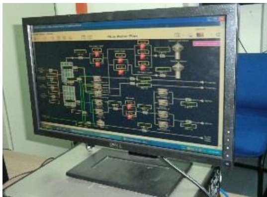
▲SCADAモニター（イメージ）
