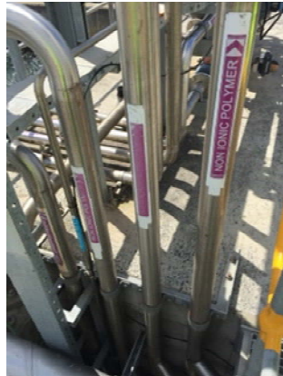
高分子凝集剤の配管
