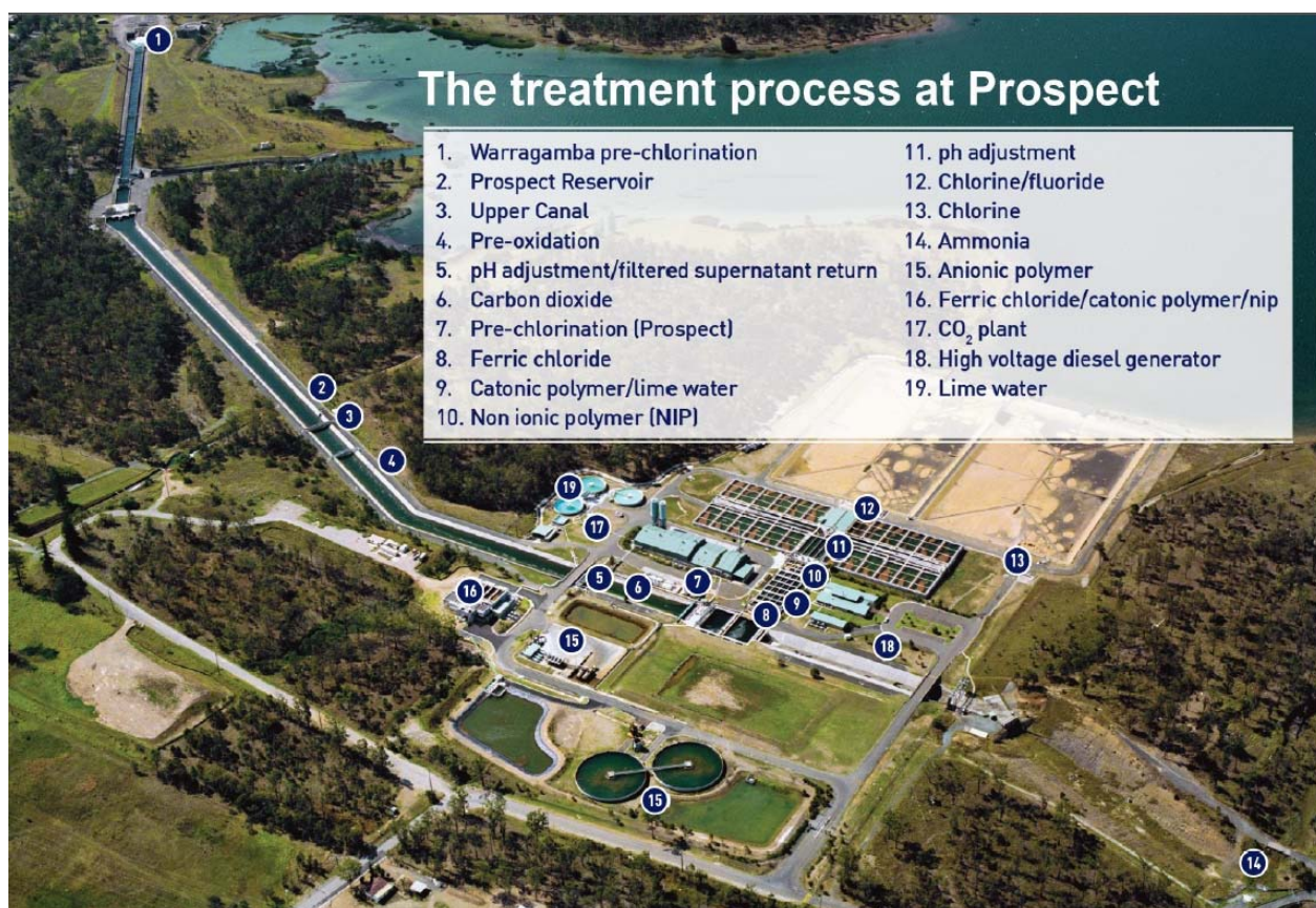
プロスペクト浄水場の全景
