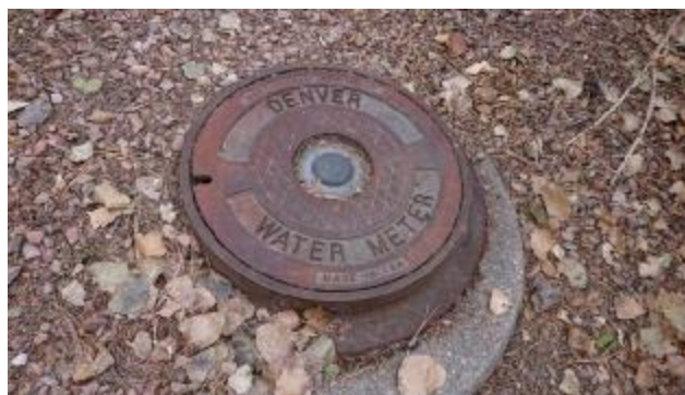
デンバー水道のメーターの蓋。 φ600 の人孔と同じサイズであった。
