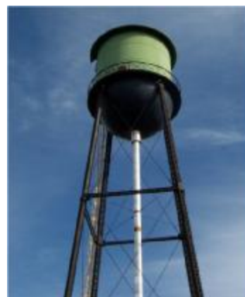
配水塔：我が前橋市の物と非常に似ている。
