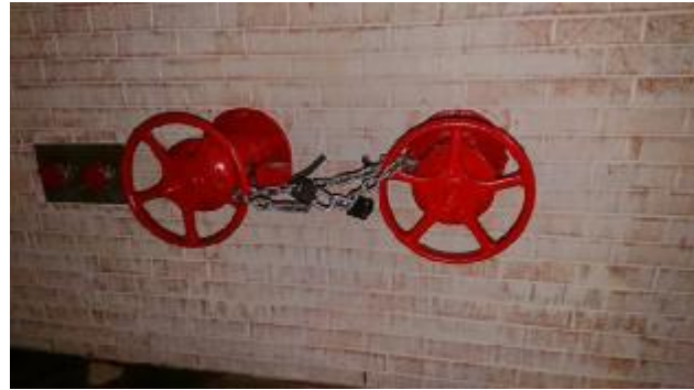
地上式消火栓とビルの壁に設置された消火栓。 地下式消火栓は見られなかった。
