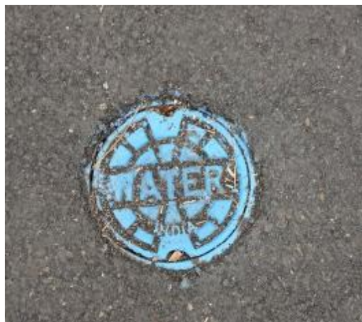
デンバー水道の 1 号弁篋。 サイズは日本と同じであった。
