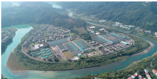
図-20 浄水場全景
