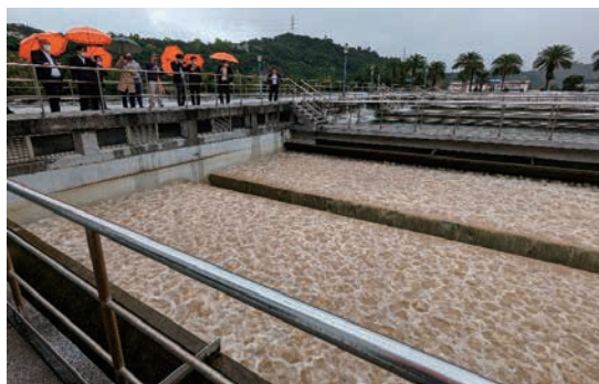
図-26 汙過池逆洗の様子
