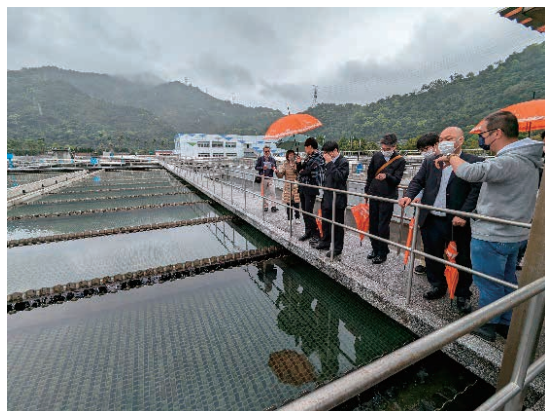
図-23 傾斜管式沈澱池
