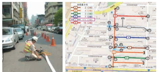
図 -18 漏水調査手法とその様子
