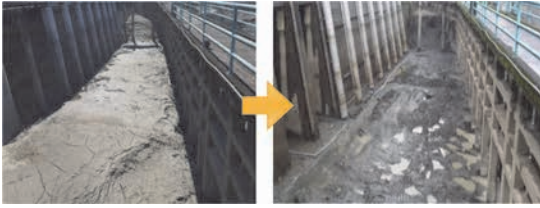
図 -27 重機による泥の除去 (施設改造前)
