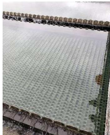
沈でん池の傾斜管
