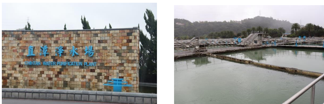
写真 5. 直潭浄水場正門 (左)、場内風景 (右)
