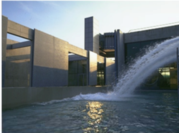
Usine de production d'eau Potable de Joinville
