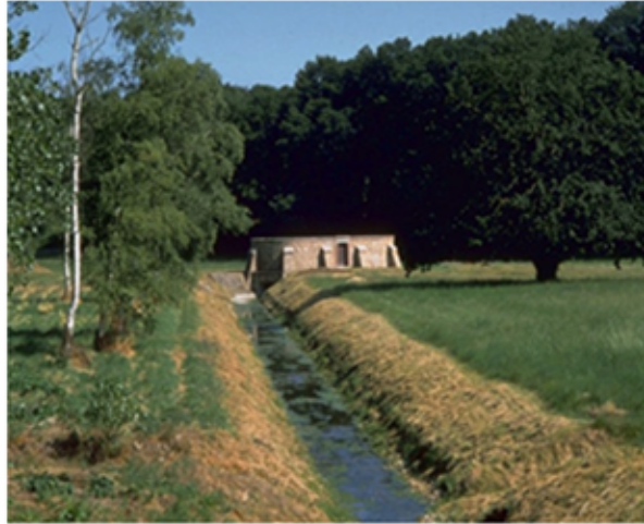
Pavillon de captage Source de Foisys (région de Dreux)
