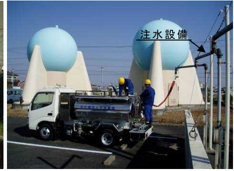
耐震性貯水槽と立上り配管による注水状況
