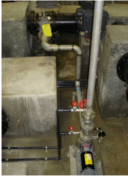
ポンプ設備による注水状況
