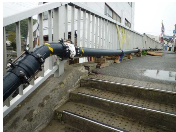
仮設配管（硬質塩化ビニル管）
