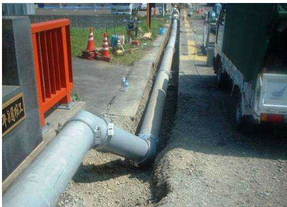
仮設配管（ステンレス管）
