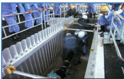
実際の埋設配管を使用した漏水探知・修繕、管路保全の知識が習得できる。
