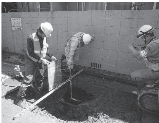
修理業者による応急復旧活動状況
