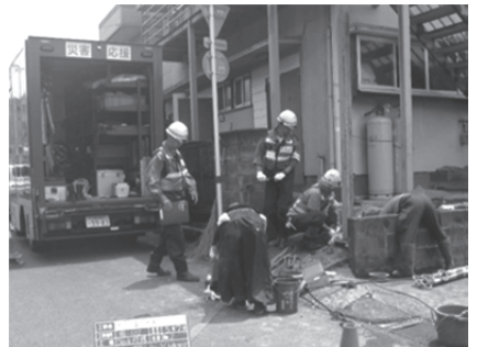
写真4 復旧工作車と漏水修理
