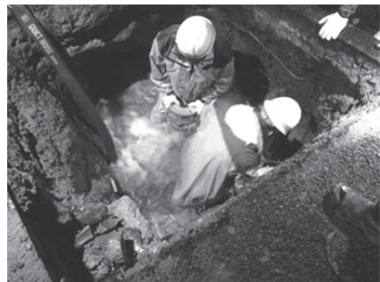
写真 1 本市での漏水修理
