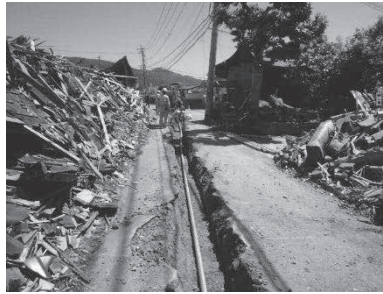
写真-5 仮設配管の施工状況
