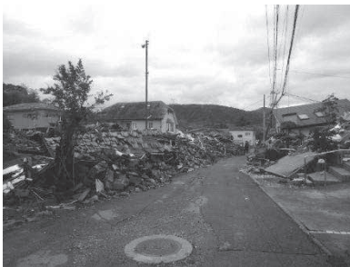
写真-4 益城町における被災状況
