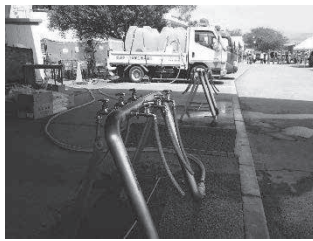
写真-2 給水装置(蛇口台)
