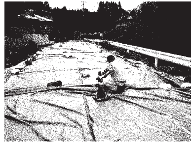
図3 御船町の作業風景
