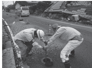
写真2 TE・TMによる復旧作業
