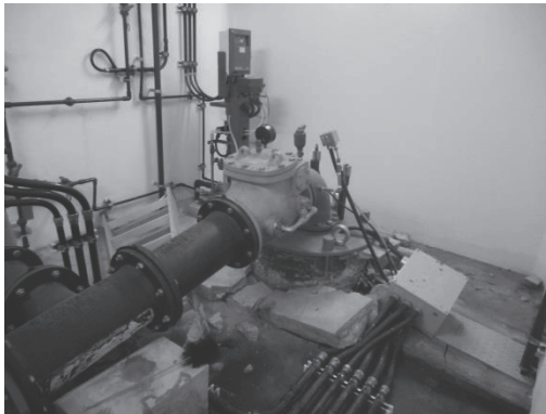
写真1 ケーシングパイプの抜上り
