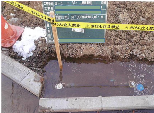
①浅層埋設部における継手漏水
