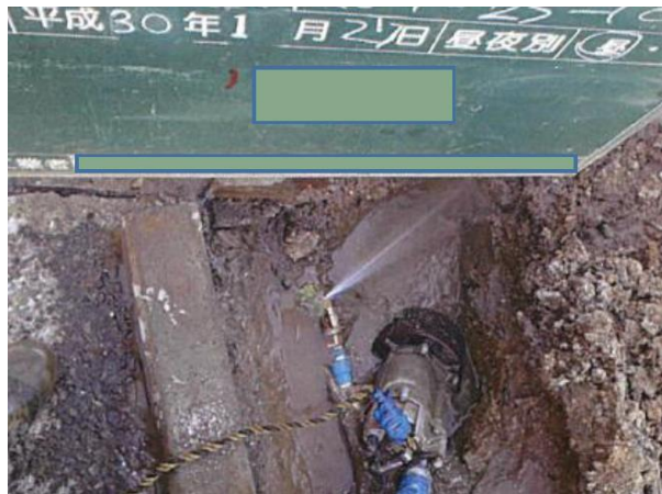
①浅層埋設部における継手漏水
