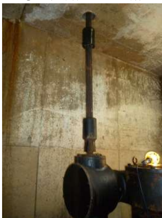
③-8（電動弁ベベルギア部）
