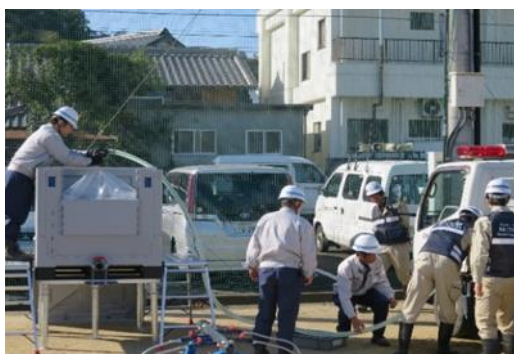
給水車から仮設水槽へ注水（徳島市）
