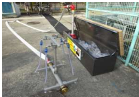
〔堺市の事例（左：給水栓使用時、右：収納時ベンチとして利用）〕
