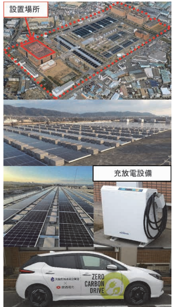
図-8 太陽光発電設備等（村野浄水場）
