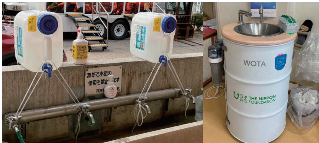
写真-4 手洗い場の例 左：水タンクの設置、右：循環型手洗い場
