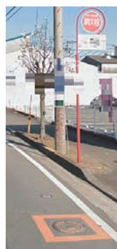
図-1 消火栓と「消火栓」標識
