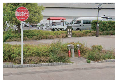
図-2 防火水槽(採水口)と「防火水そう」標識
