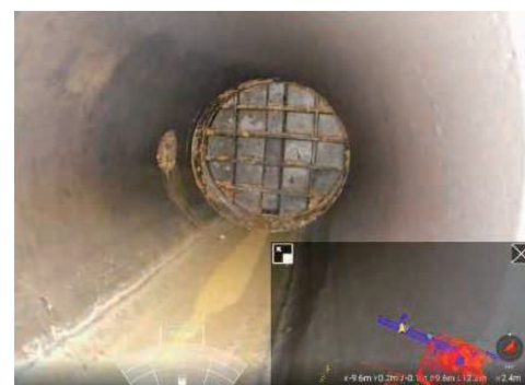
ドローン映像②(断水バルブ付近)
